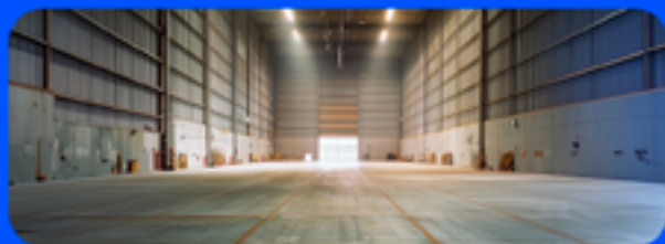
Galpão (não operacional)
